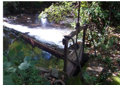
Système à vis et manivelle.
