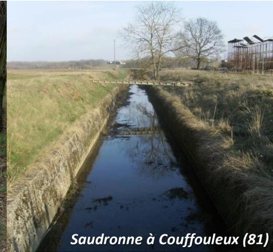
**Berges et/ou lit du cours d'eau figés dans le temps (enrochement, béton)**
