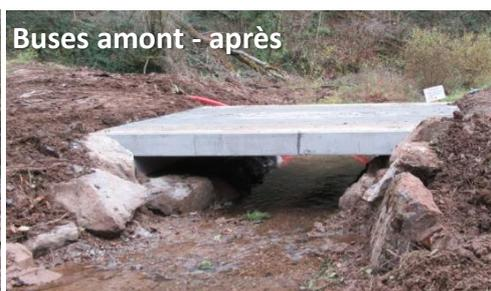
Deux passages busés situés de part et d'autres de l'ex-barrage ont également été remplacés cet automne par une passerelle et un pont afin de rétablir les capacités d'écoulement du ruisseau et la continuité écologique. Afin de limiter le risque d'inondation sur le secteur, quelques travaux de terrassement restent à réaliser en 2018.
