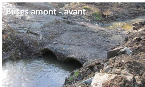
Initialement, le seuil implanté sur le Blasou, à proximité de la station d'eau potable formait un petit plan d'eau. La présence de cet ouvrage surélevait le niveau d'inondation du secteur et menaçait l'usine d'eau potable. Les effets de cet ouvrage sur le Blasou, ruisseau de 1<sup>ère</sup> catégorie, étaient également néfastes : obstacle à la libre circulation des poissons et des sédiments, réchauffement de la température des eaux, colmatage du substrat, etc...
